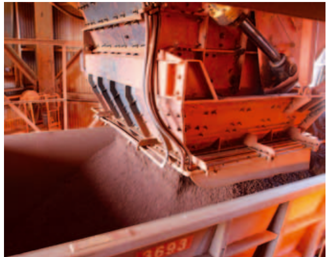
Beladung eines Zugs Train loading
